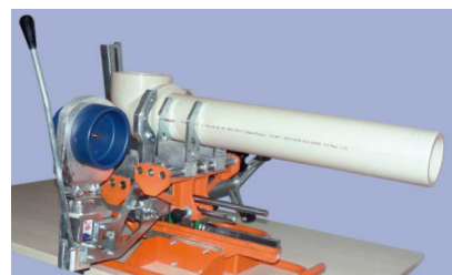
готовое сварное соединение после охлаждения
