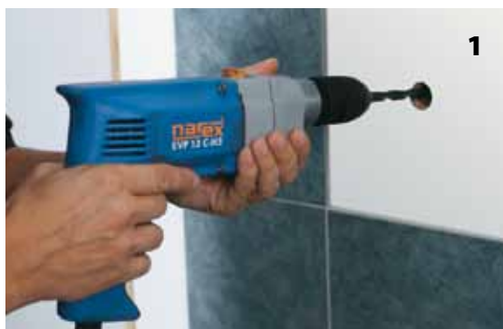
Просверленное отверстие рассверлить (откалибровать) сверлом 10 мм.
